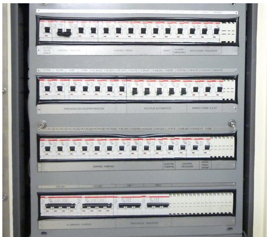
**Figura 3-17. Panel de microdisyuntores del armario C1 del carro N2 (Hoja 2 de 2).**
