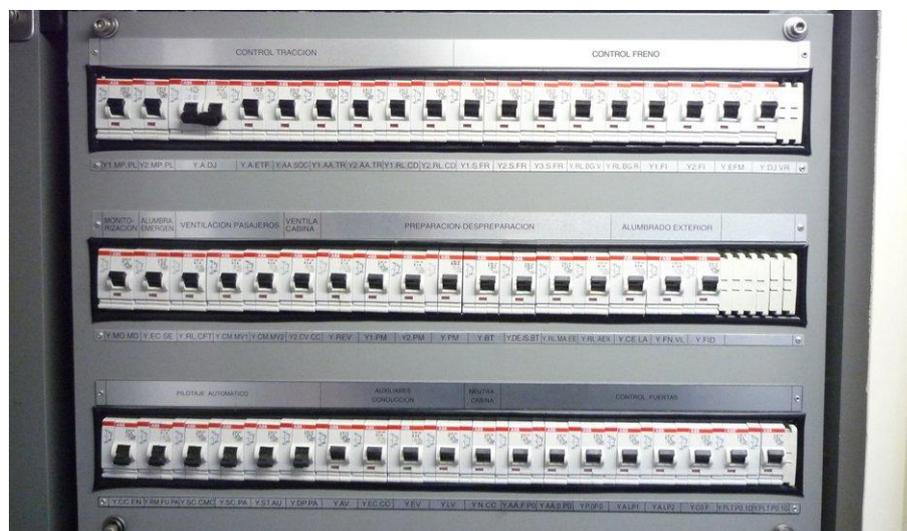
**Figura 3-13. Panel de microdisyuntores del armario C1 del carro M (Hoja 3 de 3).**
